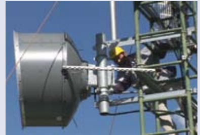
在偏鄉地區進行微波建設工程，提供電話與上網等通訊服務。
